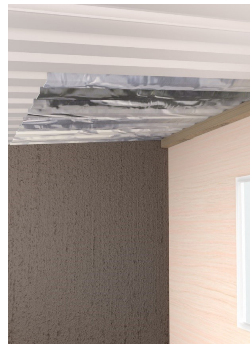
NSP MultiLayer (SOFT) PRO в якості звукоізоляції даху на балконі
